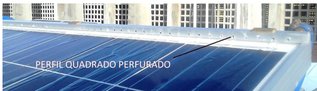
Figura 26 - Perfil quadrado de alumínio perfurado para aplicação de água.
