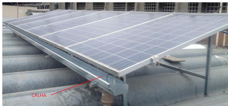
Figura 24 - Calha de recolhimento da água aplicada sobre os painéis.
