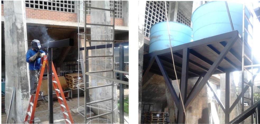
Figura 25 - Estrutura metálica construída para os reservatórios (10.000 litros).
