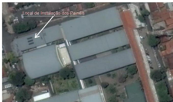
Figura 20 - Local de instalação dos painéis fotovoltaicos no Campus Goiânia, obtido pelo Google Earth com adaptações
